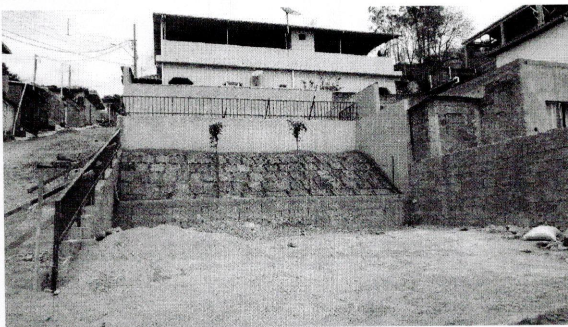
Figura 2 -Obras de construção da Praça Pública
